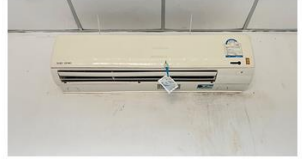
ภาพ เครื่องปรับอากาศไม่เย็น มีน้ำหยด
